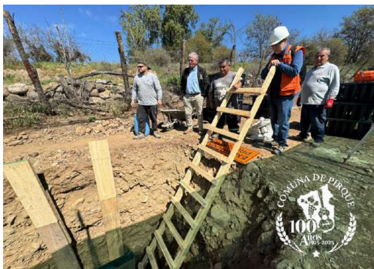
OBRAS AFUERAS LICEO EL PRINCIPAL
