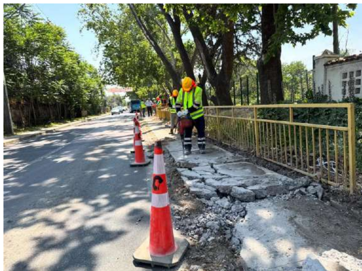
MEJORAMIENTO VEREDAS AV. VIRGINIA SUBERCASEAUX
