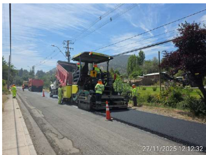
REPAVIMENTACIÓN CALLE PUNTILLA
